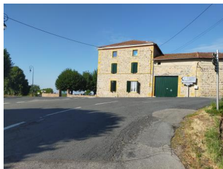
Ce n'est pas le Carrefour de l'Arbre, mais la fin de la 1 ère ascension du jour, à Villechenève
